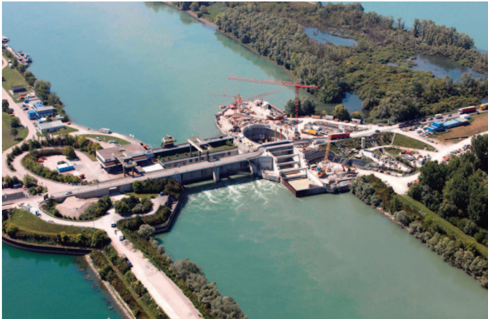
Staustufe und Wasserkraftwerk Iffezheim während Ausbauarbeiten an Maschinenhaus und Fischpass, 2011 Von EnBW AG - EnBW-Archiv, CC BY-SA 3.0, https://commons.wikimedia.org/w/index.php?curid=18095250 (09.02.2021) Rheinkraftwerk Iffezheim Ausbau 2011.jpg
